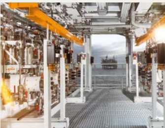
Inbetriebnahme vor Ort
